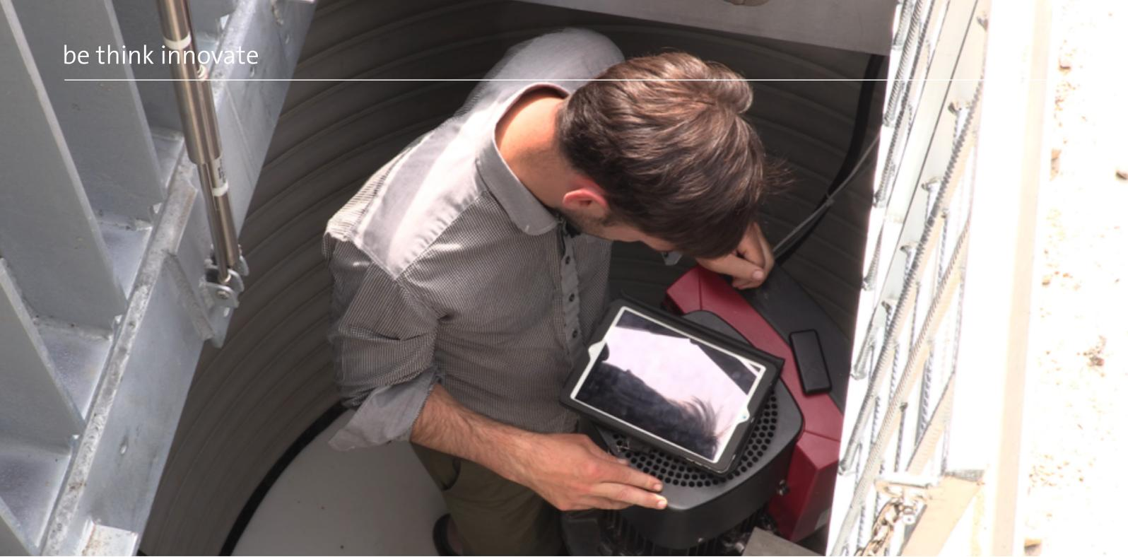
Le Directeur technique Magnus Justesen surveille la température et la vitesse de la pompe de la zone basse température de Gentofte via l'application Grundfos Go sur sa tablette.
