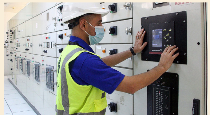
Med dedikerte styringer og et fjernstyringssystem fra Grundfos, sparte RAKWA 20 % energi og 12 % i totale driftskostnader med en oppgradering av pumpestystemet til avløpssystemet.
