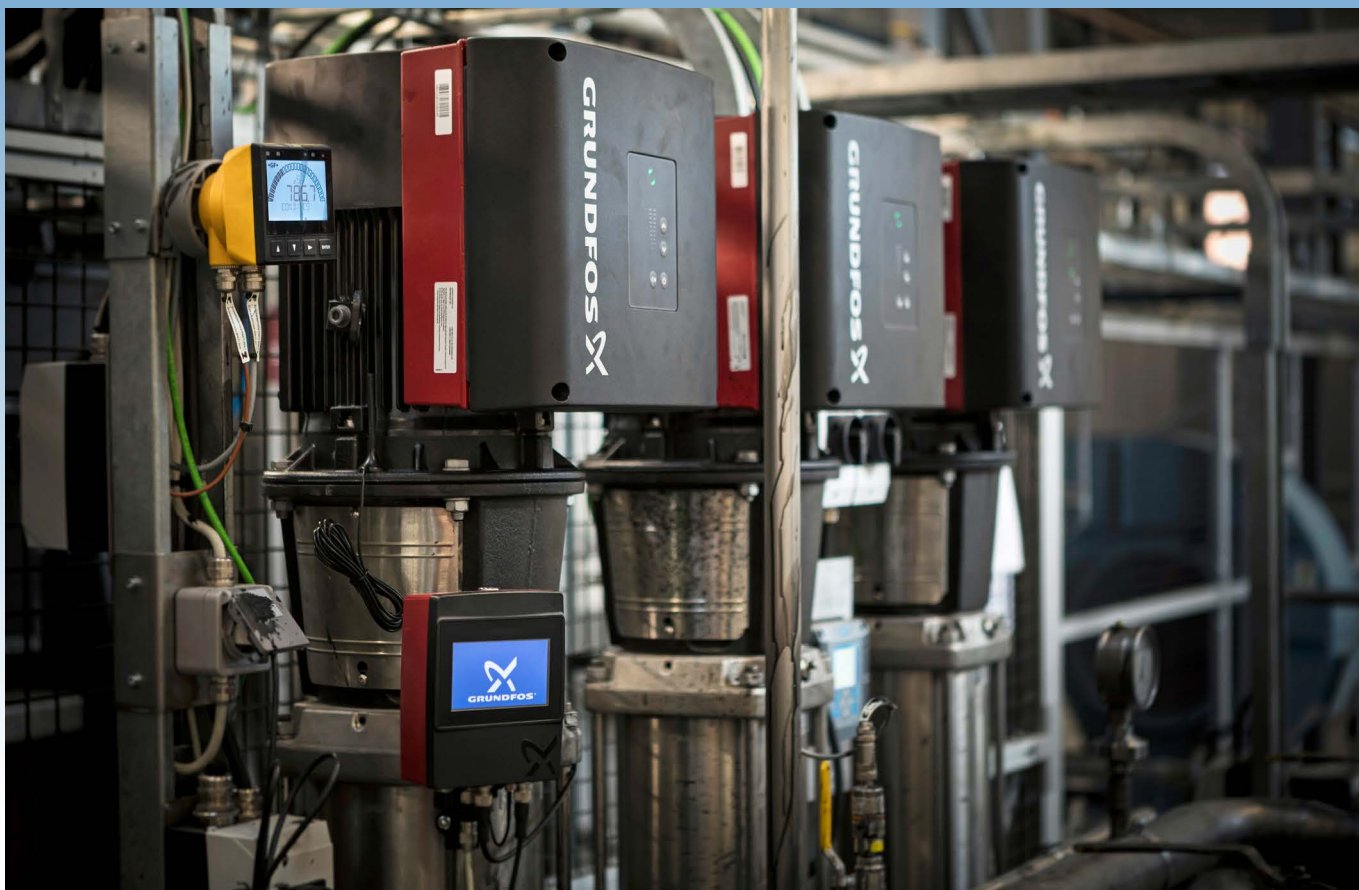
Pompy CRE Grundfos oraz urządzenie Grundfos Condition Monitoring pracują na zbiorniku z lakierem w linii technologicznej do powlekania CED i obróbki powierzchniowej w firmie BIRN.
