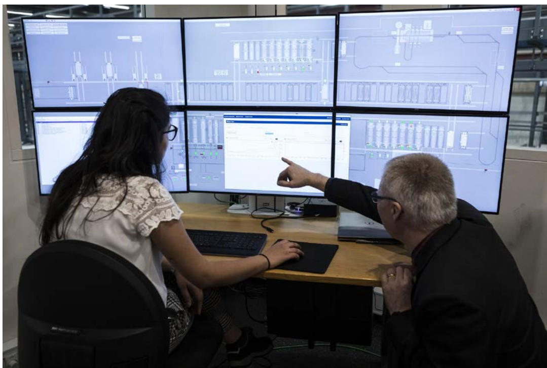
Pełny przegląd i kontrola procesu mycia i czyszczenia
